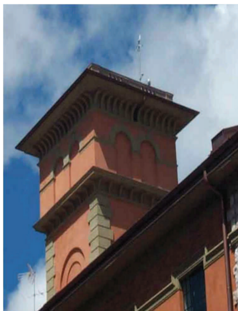
FIGURA 133: LA TORRE DEL MOLINO VITTORIA, DOVE È INSTALLATO L'OSSERVATORIO METEOROLOGICO DELL'UNIVERSITÀ DEGLI STUDI DI TRENTO [2]
