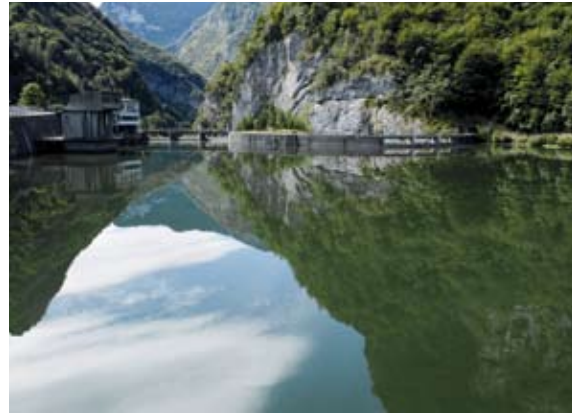
Bacino idroelettrico nel Vanoi.
