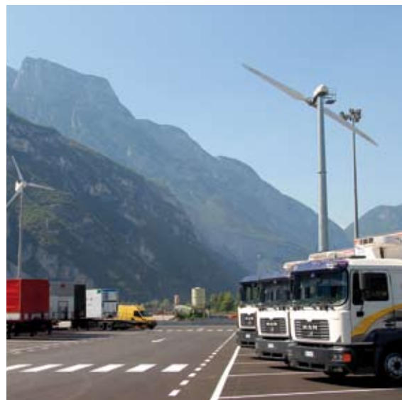
Il Campo eolico sperimentale a Trento Nord realizzato dalla Provincia autonoma in collaborazione con l'Università di Trento.
